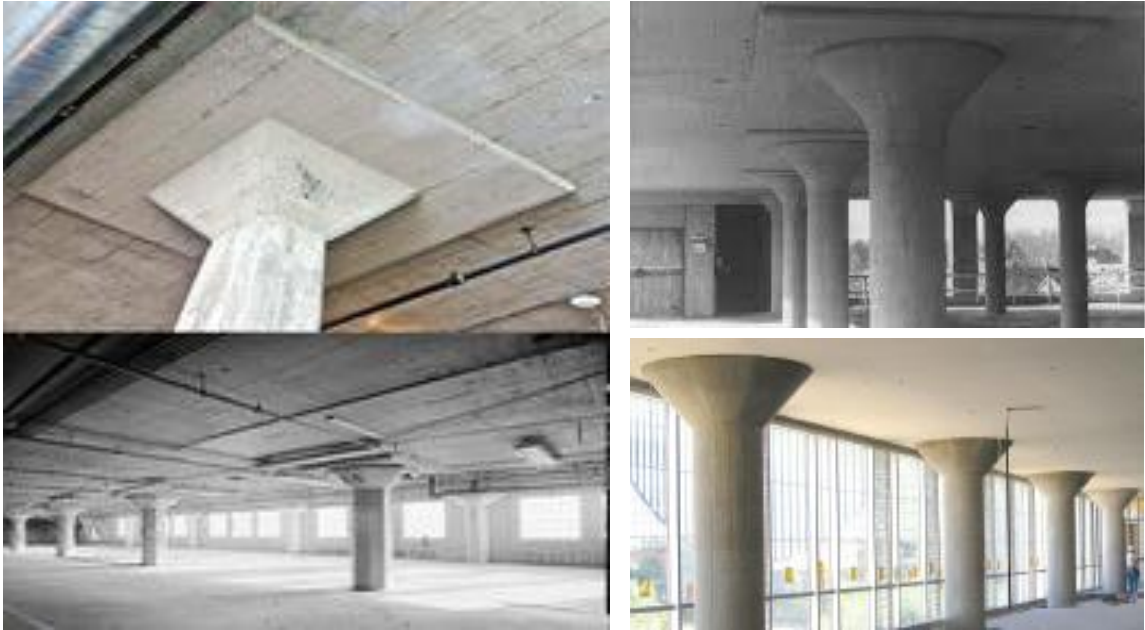
Şekil 1.10. Kirişsiz döşeme tabla ve başlık boyutları ile uygulama örnekleri
